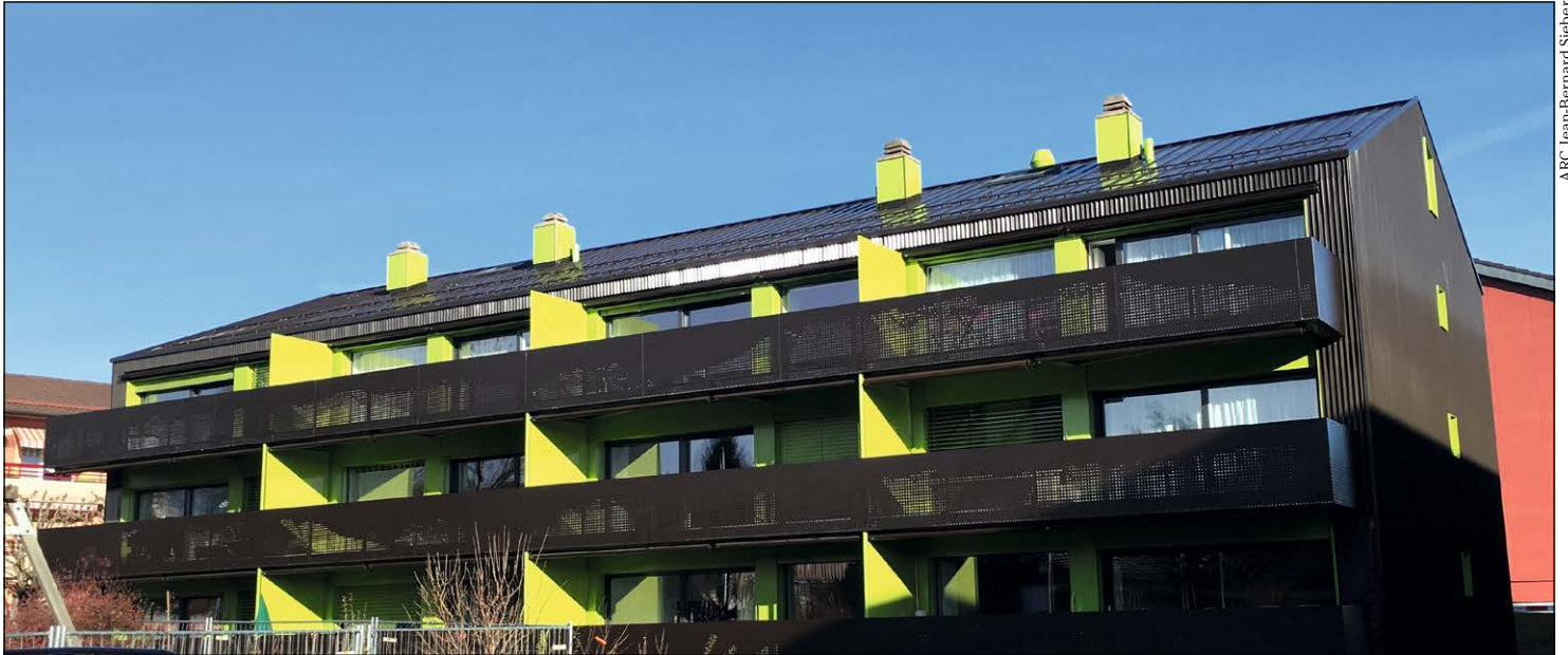
Transformation d'un chauffage avec pompes à chaleur dans un bâtiment rénové à Savigny.
