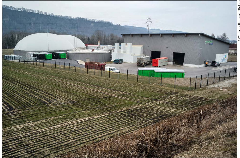
La centrale de biogaz de Treize-Cantons alimente 1200 ménages des alentours et fournit de la chaleur à l'entreprise Nestlé Waters. Elle contribue au séchage de capsules de café recyclées.
